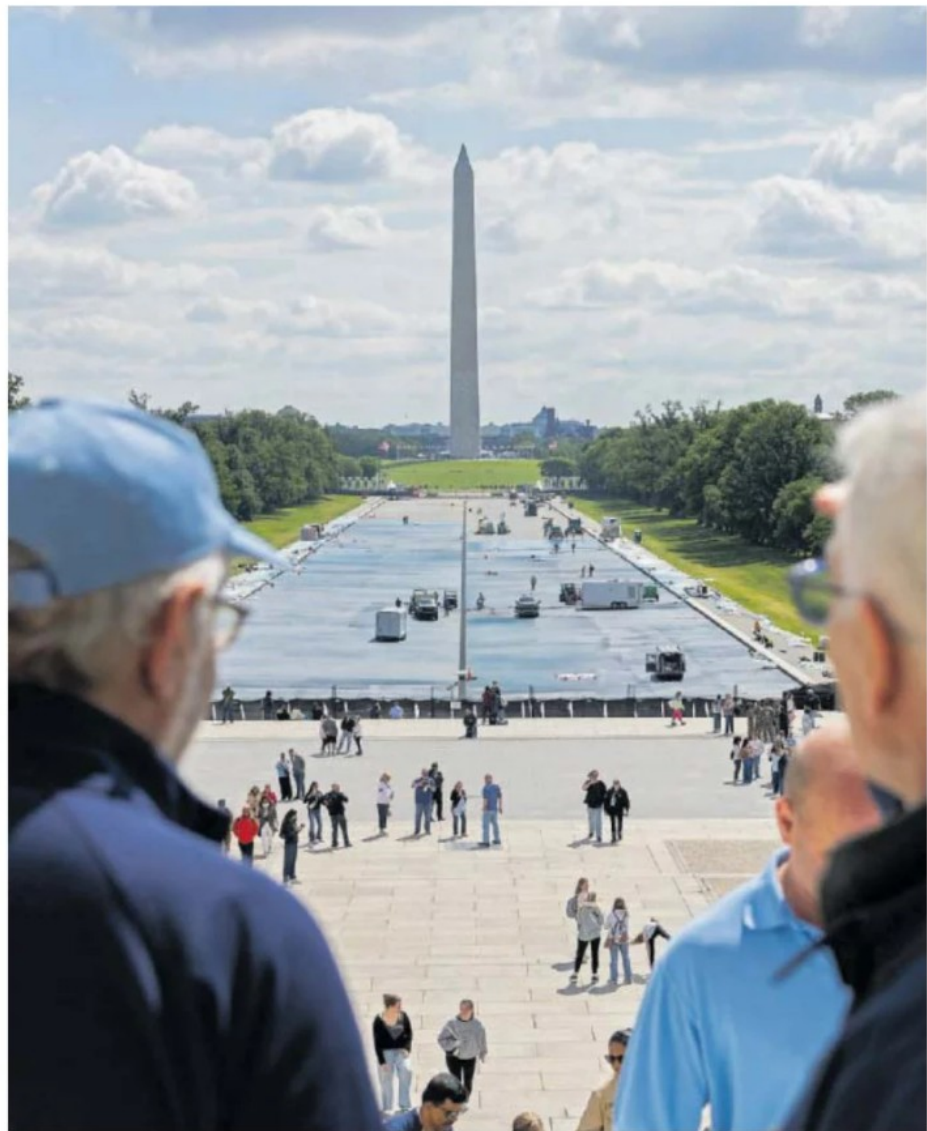
Obras de remodelación de la piscina reflectante, el 14 de mayo en Washington. CARLOS ROSILLO
